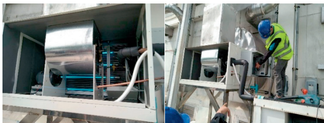
รูปที่ 59 การติดตั้งระบบ UVGI ใน AHU
