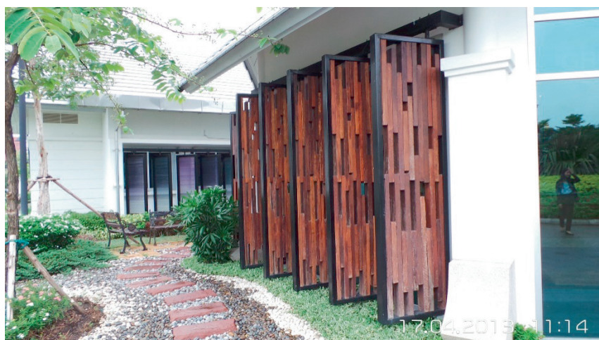
รูปที่ 26 ตัวอย่างการเก็บพื้นไม้เดิมนำมาประยุกต์ใช้เป็นแผงบังแดด
