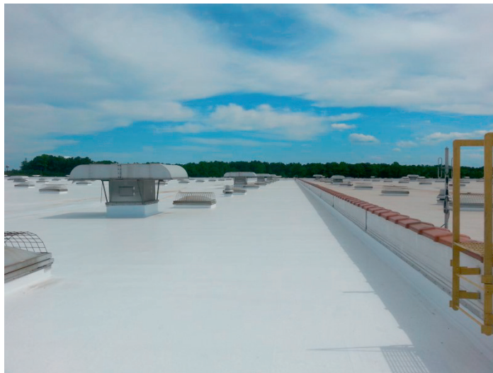
รูปที่ 31 การใช้ ceramic coating ทาบนหลังคา
